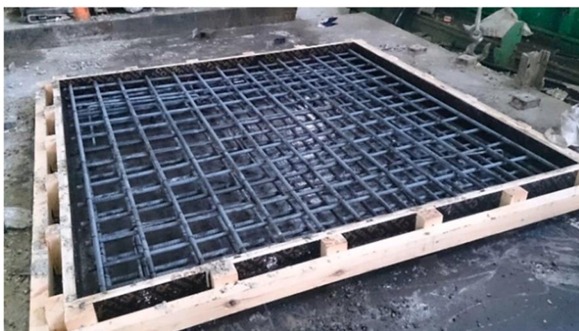
Figura 2.25 – Laje de referência, pré-concretagem (Shatarat & Salman, 2022)
