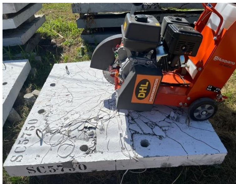
Figura 4.25 – Realização do corte na laje SC5-750.
